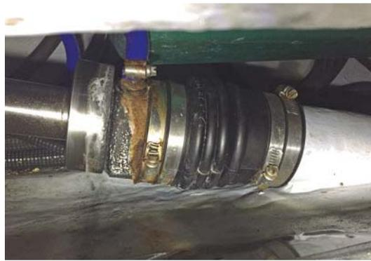
Incluso las juntas del tipo PSS, si no están correctamente instaladas, pueden causar fugas importantes.
